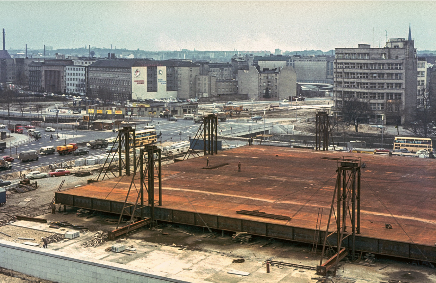
Das Dachtragwerk wird mittels einer Hydraulik-Anlage in Position gebracht. © Heinz Oeter
